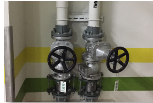
污水改善 - 雨水管路獨立配置
