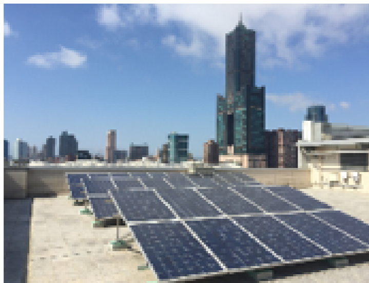
屋頂設置太陽能板提供再生能源
